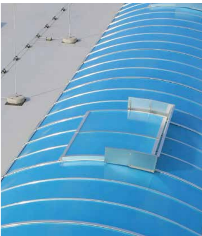
Structuur van de LAMILUX GFUP-beglazing
